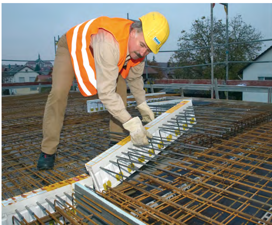
Mise en œuvre de rupteurs Rutherma® K
